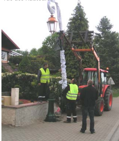
Remplacement d'un lampadaire rue des Hauteurs
